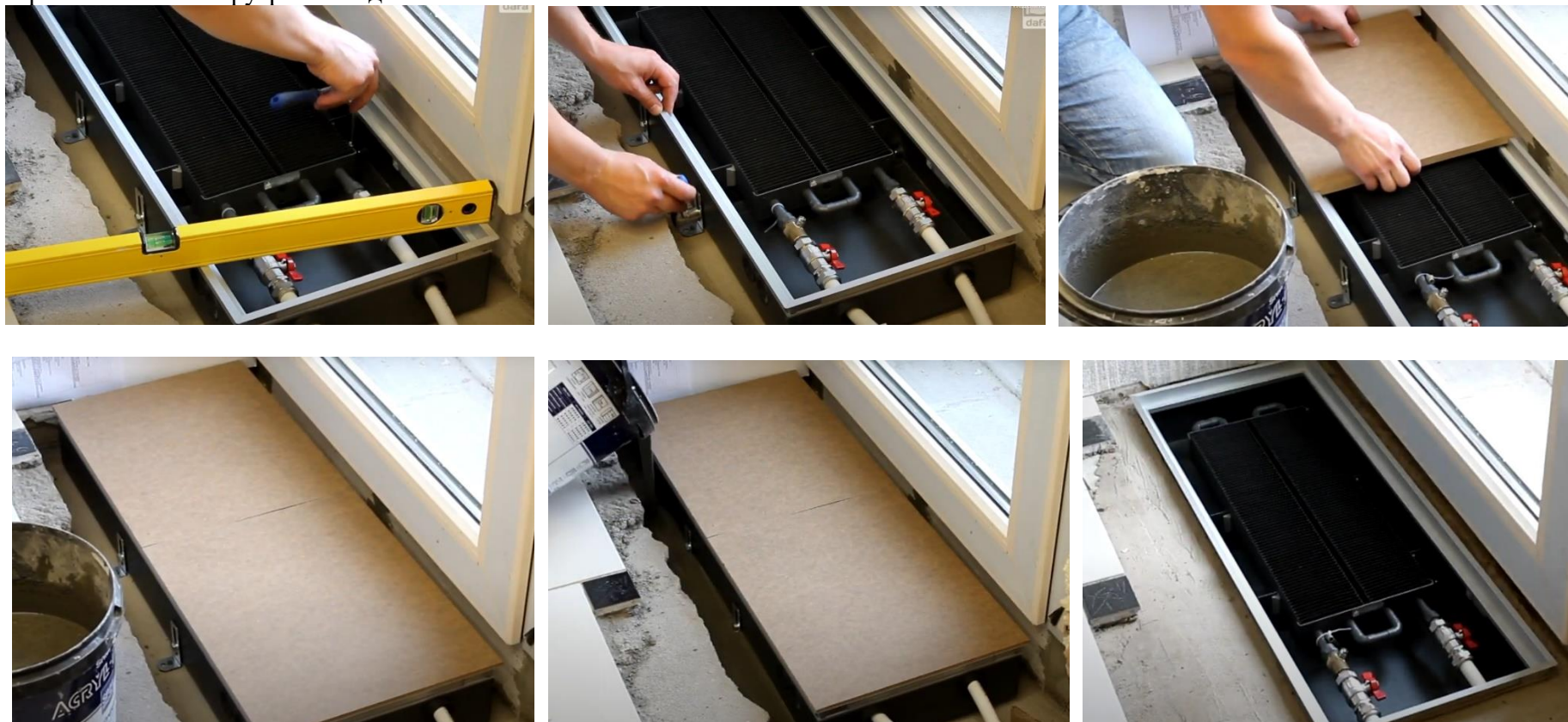
2.7-сурет – Конвектор деңгейін қою және өздігінен нивелирлейтін сұйық цемент ерітіндісін құю
