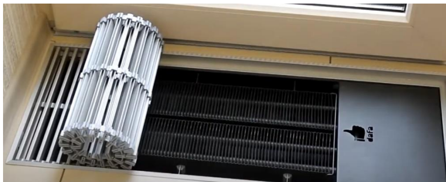
2.8-сурет – Корпус жиектемесінің сәндік профилін орнату
